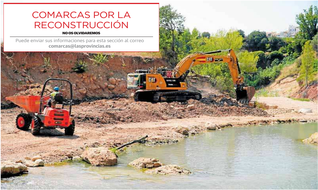
Obras de emergencia en el río Buñol, gravemente alterado por la dana. LP
