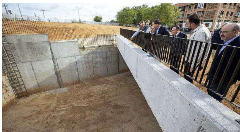
El alcalde, los concejales y los técnicos visitaron la zona de construcción del arenero de Azucaica. / YOLANDA LANCHIA
