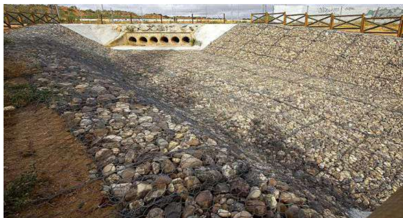
La finalización de la primera fase de las obras está pendiente de la plantación de 61 pinos. / YOLANDA LANCHIA
